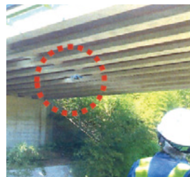
ドローンによる 橋梁点検の様子
